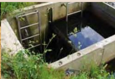
Restauration d'ouvrages hydrauliques
