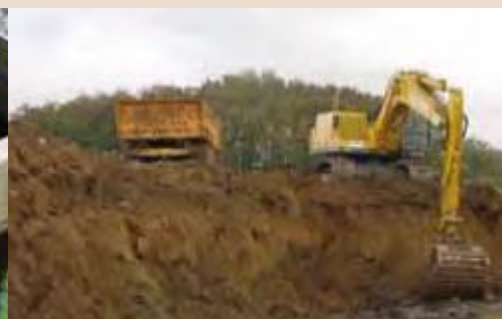
Suppression de remblai en zone humide
